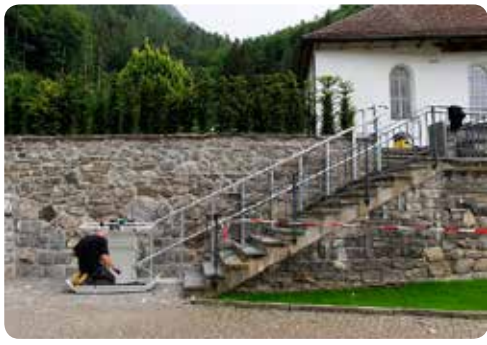
Abschlussarbeiten am Treppenlift.
