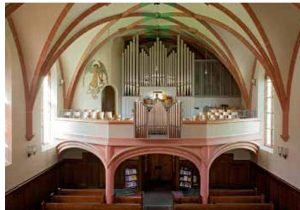
Die ziegelroten Kreuzrippen sind aus Gips und haben keine tragende Funktion.
